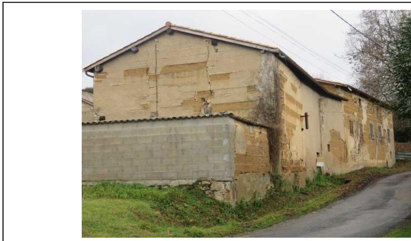
*Fissurations verticales de la façade en pisé banché sur pierres ourdées (chemin du Petit Fromentin). Vraisemblablement lié au travail de la charpente.*
